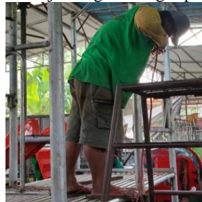
Gambar 2. Pekerja mengelas dengan posisi berdiri
