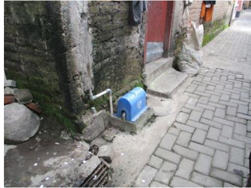
Meteran air yang sudah terpasan ditutup agar tidak mudah rusak
