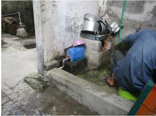
Pemasangan meteran air agar mudah untuk menghitung tagihan
