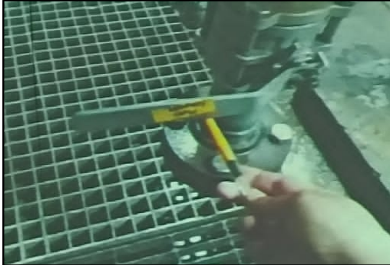
Gambar 2. katup yang kurang kencang (Sumber: Kerja Praktek PT. RAPP, 2023)
