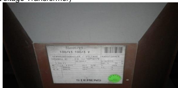
Gambar 10. Trafo Tegangan
