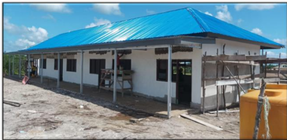
Gambar 6. Pembangunan Fasilitas Pendidikan
