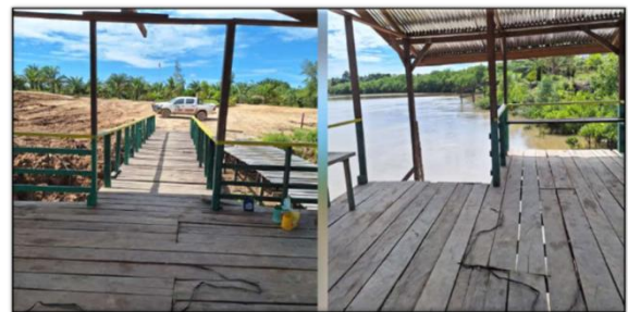
Gambar 2. Pembangunan Dermaga MBI
